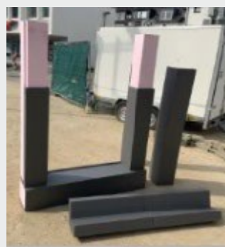
Fensterbank EPS-Muster inkl. Mustermontage Kontrolle der Anschlusssituation
